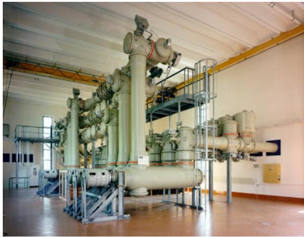
Las **Subestaciones Eléctricas aisladas en gas** usan este fluido para el **aislamiento eléctrico** de sus distintos componentes -maniobra, medición, barras, etc.- de alta tensión.
